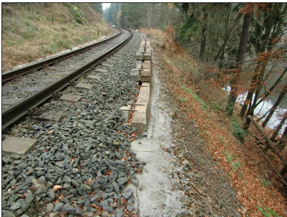
Obr. č. 2 – Provizorně zajištěný násyp pohled směr Karlovy Vary
